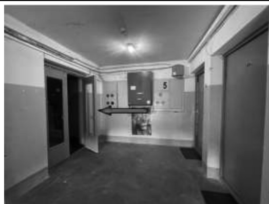
5.stāva kāpņu telpa
